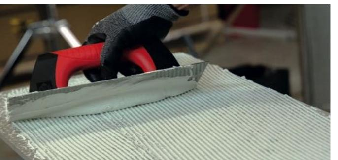
MAKE SURE THE THICKNESS OF THE LAYER OF ADHESIVE CEMENT IS UNIFORM · Asegúrate de que el grosor de la capa de cola sea uniforme · Veiller à ce que l'épaisseur de la couche de colle soit uniforme · Vergewissern Sie sich, dass die Kleberschicht gleichmäßig ist
