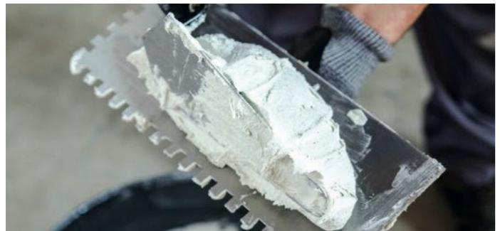
SPREAD THE ADHESIVE CEMENT WITH A TOOTHED TROWEL · Extiende el cemento de agarre con una llanta dentada · Étende le ciment à prise rapide à l'aide d'une spatule dentée · Verstreichen Sie den Klebemörtel mit einem Zahnpachtel
