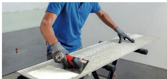
SPREAD THE ADHESIVE CEMENT WITH A TOOTHED TROWEL ON THE TILE · Extiende el cemento de agarre con una llanta dentada sobre la pieza · Étende le ciment à prise rapide à l'aide d'une spatule dentée sur la pièce · Verstreichen Sie den Klebemörtel mit einem Zahnpachtel auf der Fliese
