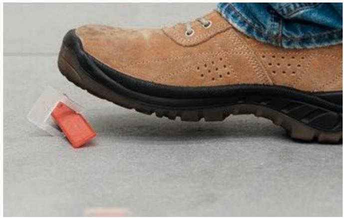
Una vez fraguado el cemento cola, para arrancar el soporte basta con golpear con el mazo de goma o con la punta del pie en la dirección de la junta.
