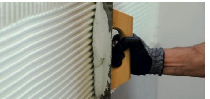
MAKE SURE THE THICKNESS OF THE LAYER OF ADHESIVE CEMENT IS UNIFORM · Asegúrate de que el grosor de la capa de cola sea uniforme · Veiller à ce que l'épaisseur de la couche de ciment colle soit uniforme · Vergewissern Sie sich, dass die Kleberschicht gleichmäßig ist
